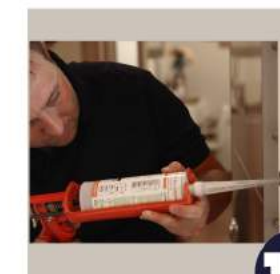
INSTALACIÓN SIN OBRA
